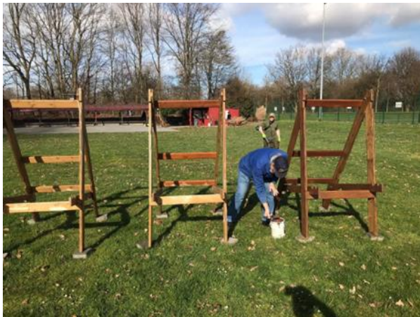
Die Scheibenstände kontrolliert und repariert
